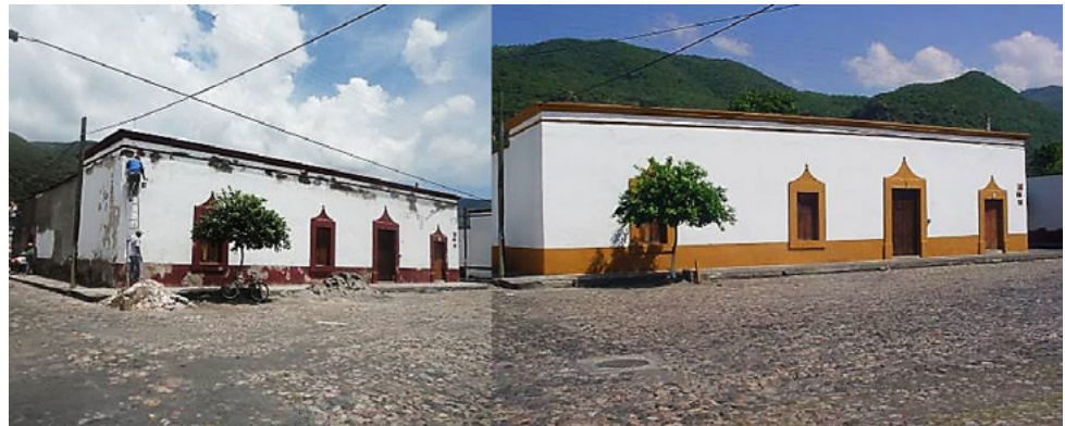
Figura 4. Antes y después del proceso de mantenimiento en fachadas.
