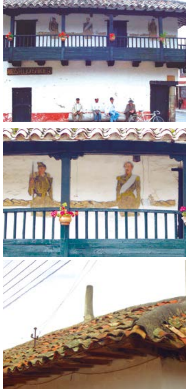
Figura 22. Casona antigua, aproximadamente de 1750. Detalle de los murales alusivos a la Independencia y vestigio de una chimenea en la vivienda
