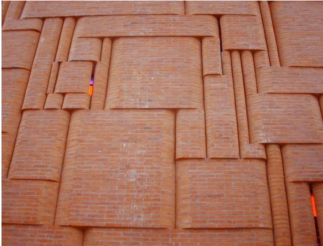
Figura 3. Horacio Torres, 1958. Detalle de Mural en ladrillo. Seminario Arquidiocesano de Toledo. Arquitecto Mario Payssé Reyes. Fotografía archivo propio, 2004.
