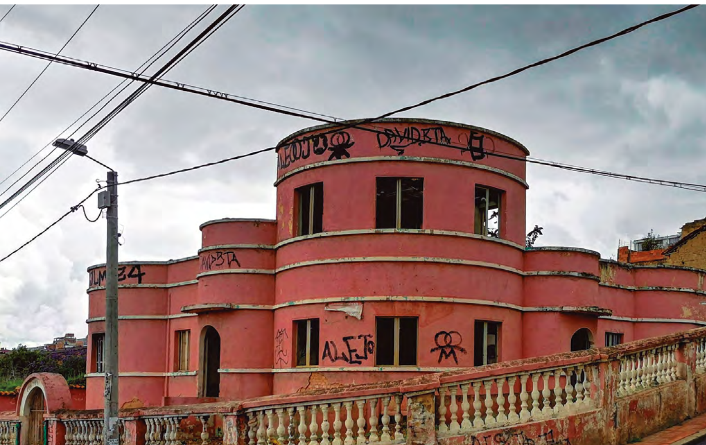
Figura 11. La casa rosada, antiguo terminal, Tunja
